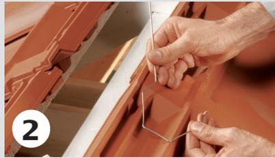
**2** Zur einfachen Installation des Drahtes wird dieser aufgebogen und in Abständen von ca. 42 cm in die letzte Dachlatte (rechts und links im Wechsel) eingehängt.
