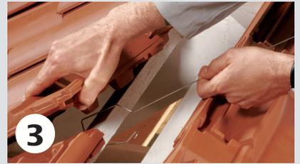
**3** Leichtes Anheben des Ziegels erleichtert das Einhängen des Drahtes. Alternativ kann der Firstklammerdraht vor dem Auflegen der Firstanschluss-Lüfterziegel eingehängt werden.
