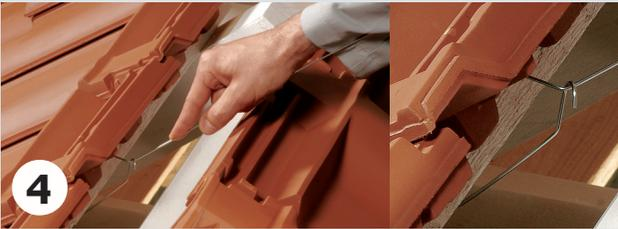
**4** Der Firstklammerdraht wird nach dem Einhängen in die Lattung geschlossen.
