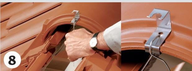
**8** Der Draht wird mit der Hand nach oben gezogen (gespannt) und anschließend nach unten abgebogen. Dadurch verkrallt sich der Draht im Führungsschlitz der Firstklammer.
