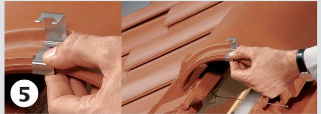
**5** Aufstecken der Edelstahl-Firstklammer auf die Verfalzung des Firstziegels.
