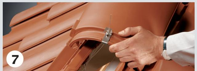
**7** Der Firstklammerdraht wird durch den vorgelochten Firstziegel und die aufgesteckte Edelstahl-Firstklammer geführt.
