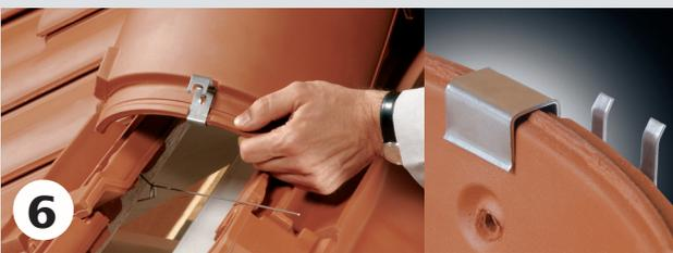
**6** Die Edelstahl-Firstklammer kann beim Montieren durch ihre Passgenauigkeit und Federkraft nicht mehr vom Firstziegel abfallen.
